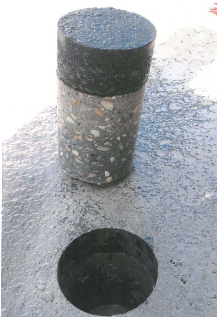
1. kép: Fúrást követően Nyíregyháza, Damjanich utca 0+055 km. sz. jobb oldal tengelytől 1,9 m
